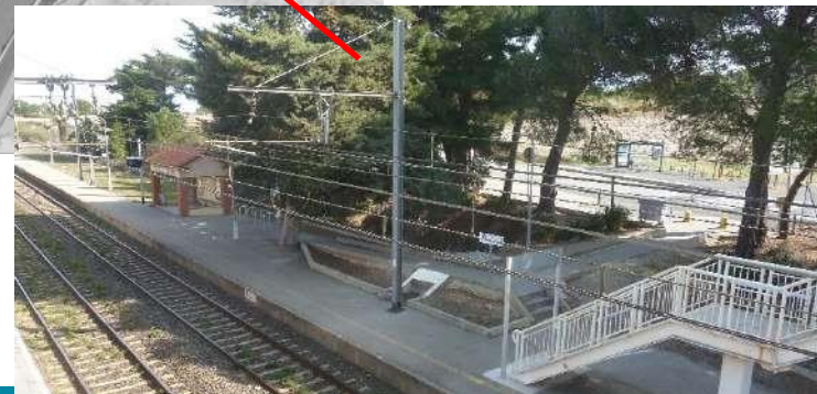
→ Vue du quai Est de la Gare, sur la passerelle
