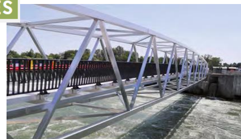
9. PASSERELLES À TABLIER EN ALUMINIUM
