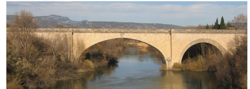
Pont de la N109 sur l'Hérault
