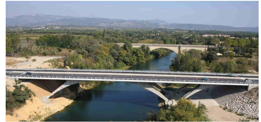
Viaduc de l'A750 sur l'Hérault
