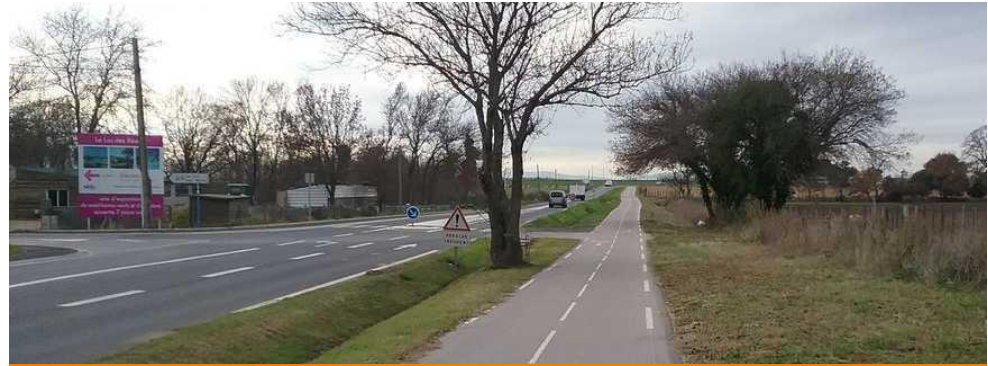
Piste cyclable éloignée de la chaussée
