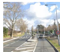
Photo 1 : site de l'accident mortel
