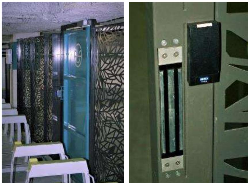
*Rouen Saint-Sever – Solution de contrôle des accès – ventouse électromagnétique, lecteur RFID, UTL permettant la gestion décentralisée des droits d'accès.*
