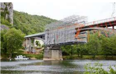
Travaux de rénovation de voiries, de routes ou d'ouvrages d'art
